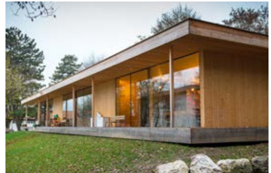
Schnell und sicher: Kindergarten in 2 Tagen fundiert.
