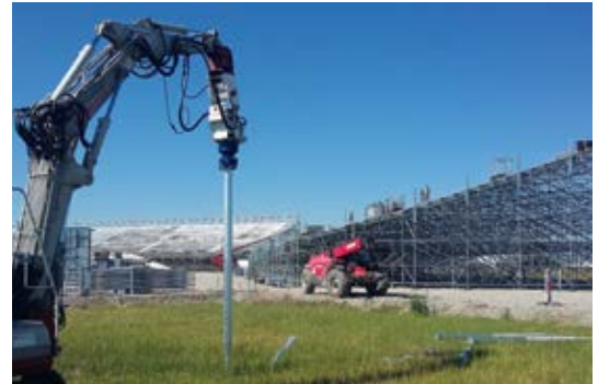
Auch für temporäre Installationen und hohe Lasten – Tribünenbau eidg. Schwingfest
