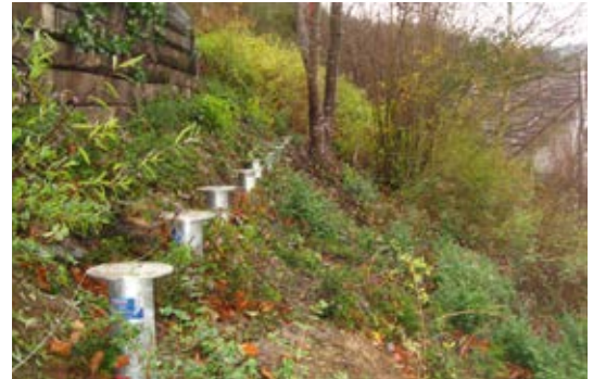
Schraubfundamente – die kostengünstige Alternative ohne Aushub, Beton und Wartezeit
